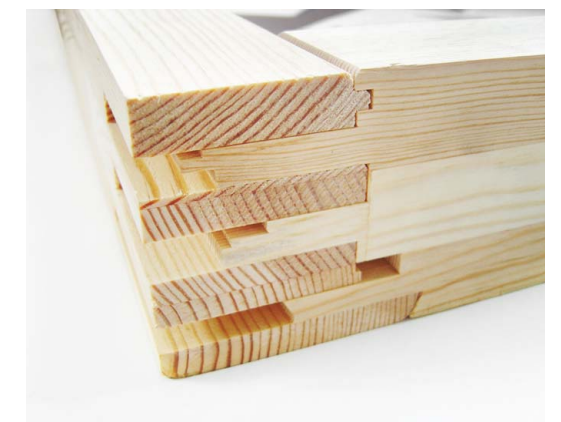
A rövidített csapok lehetővé teszik a tolnyílások pontos zárását.
